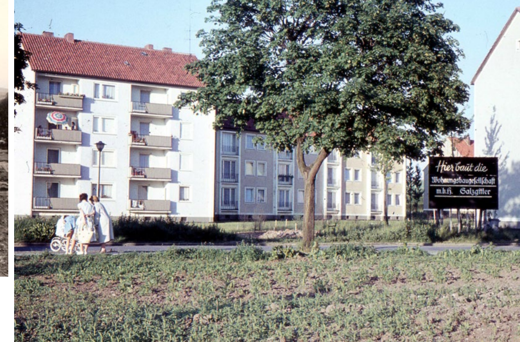
Baustelle am Hasenspringweg in den 1950er Jahren.
