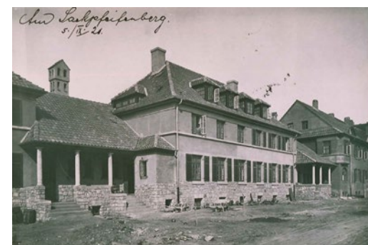
Auch die bereits im Jahr 1921 fertiggestellten „Beamtenwohnungen“ am Sackpfeifenberg in Peine (hier ein Archiv-Foto kurz vor der Fertigstellung) gehören heute zum Bestand der Wohnbau.
