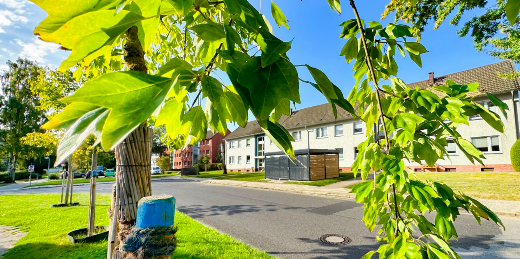
Der Berliner Ring in Peine, vor den Häusern einer unserer großzügigen Fahrradgaragen mit ökologischer Dachbegrünung.
