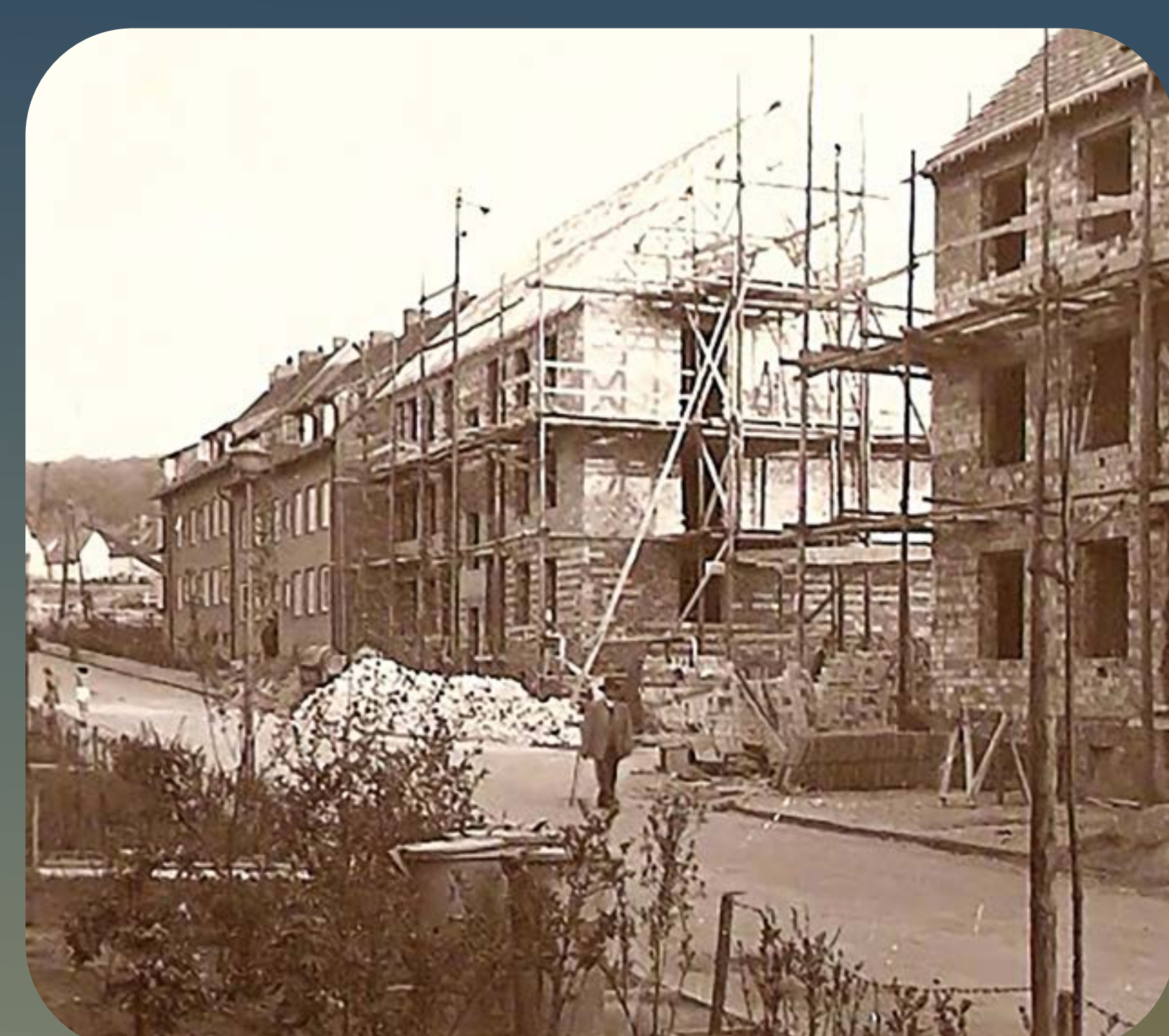
Aufnahme erheblicher Instandsetzungsarbeiten in den Nachkriegsjahren, die auf Grund der Währungsreform umgesetzt werden konnten.
