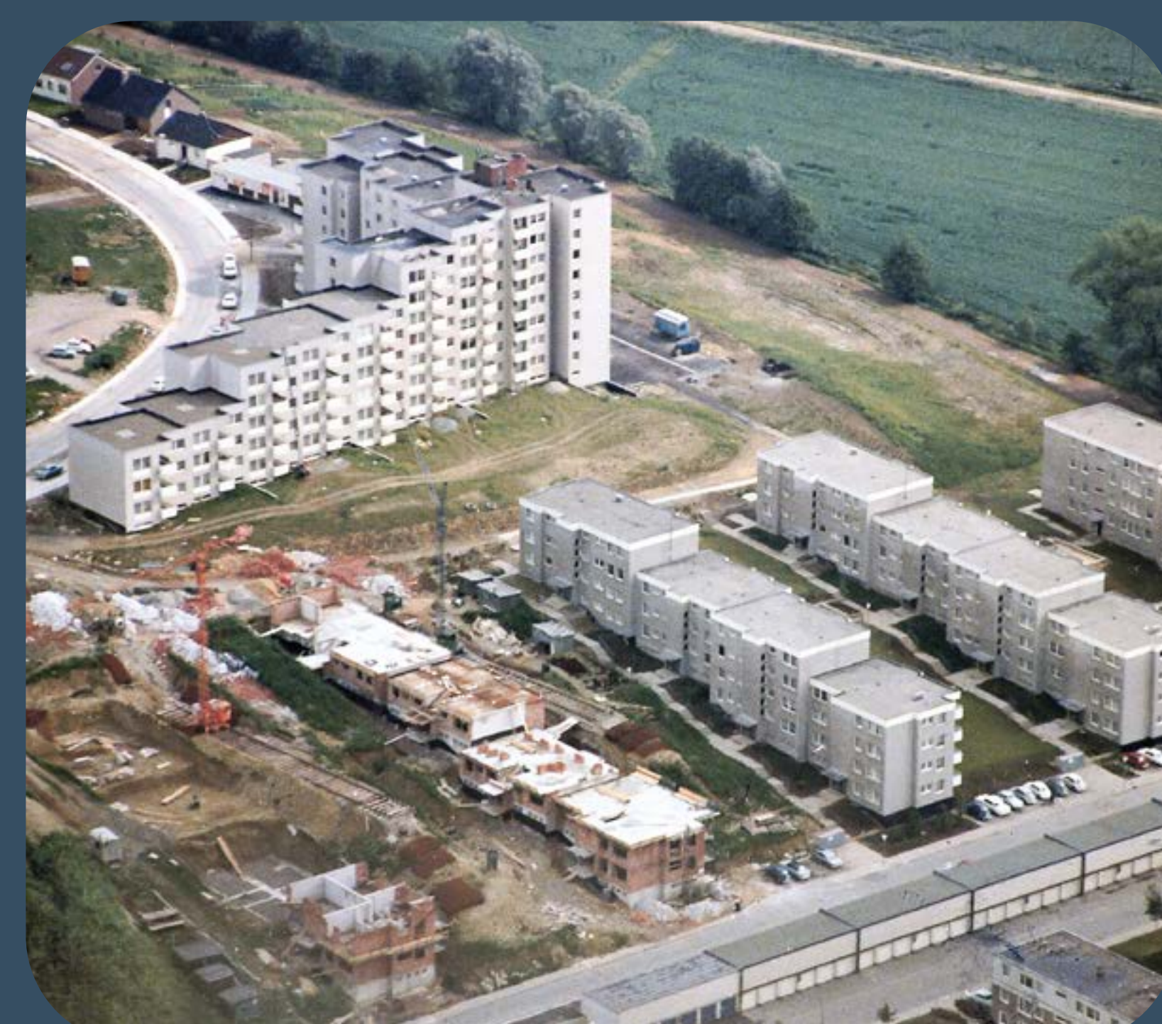
Links: Wohnanlage Franz-Zobel-Straße im Volksmund auch „Wohnburg“ genannt.
