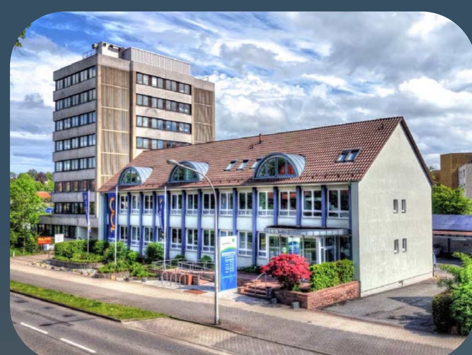
Kundenzentrum Windmühlenbergstraße, SZ-Bad
