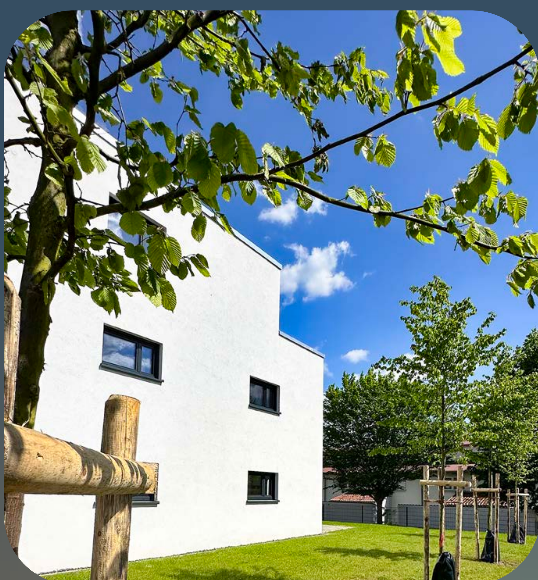
Neubau von Stadthäusern in ruhiger Lage am Finkenweg in Salzgitter-Bad.
